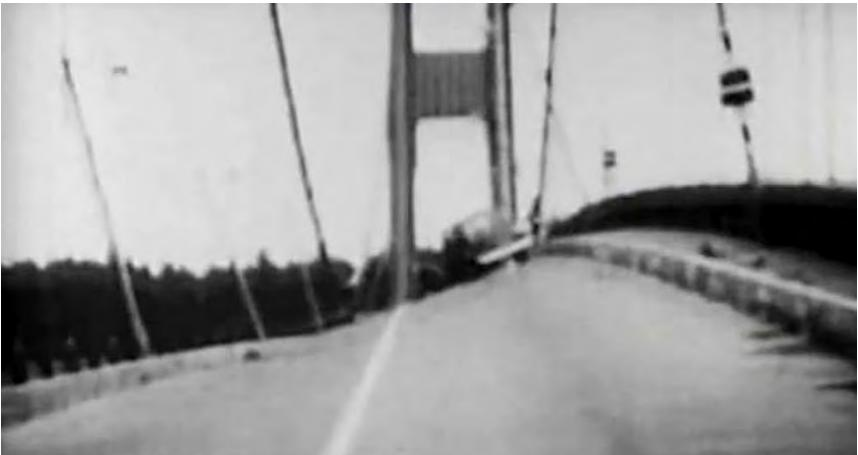
Was als leichtes Schwanken begann, entwickelte sich unter dem Einfluss von Windböen in eine immer heftigere Torsionsbewegung – bis die Konstruktion schließlich wie in Zeitlupe zusammenbrach. Nicht Materialversagen im klassischen Sinne war schuld, sondern ein schleicher, unterschätzter Taktgeber.
